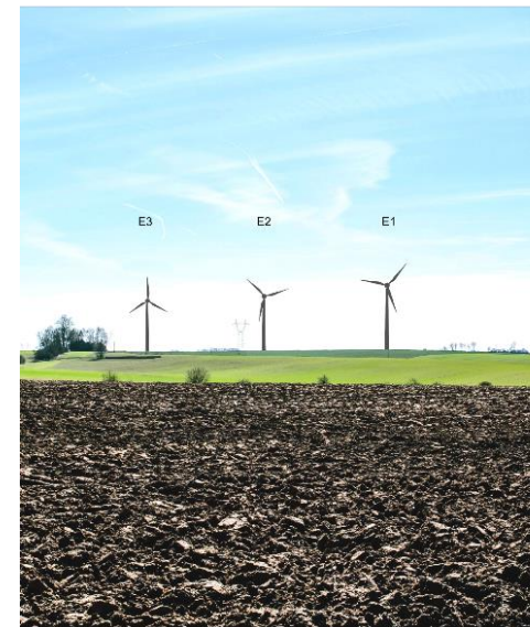
Montbréchain (02) – Parc éolien de 6,9 MW autorisé
